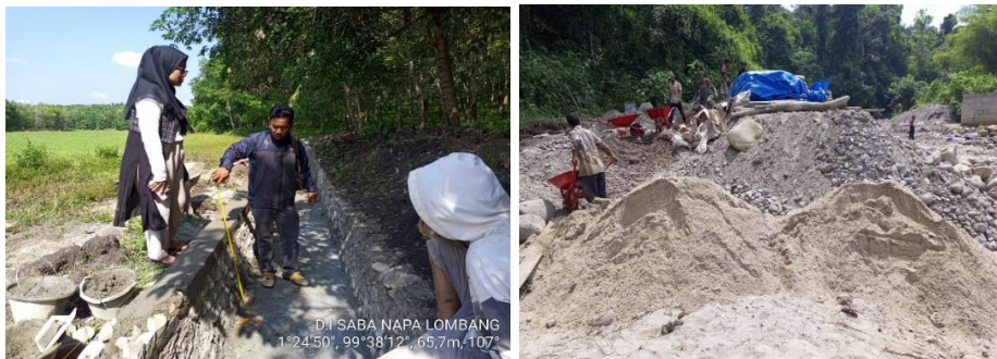
Gambar 2 . Pekerja Pembangunan Pelebaran Saluran Irigasi
